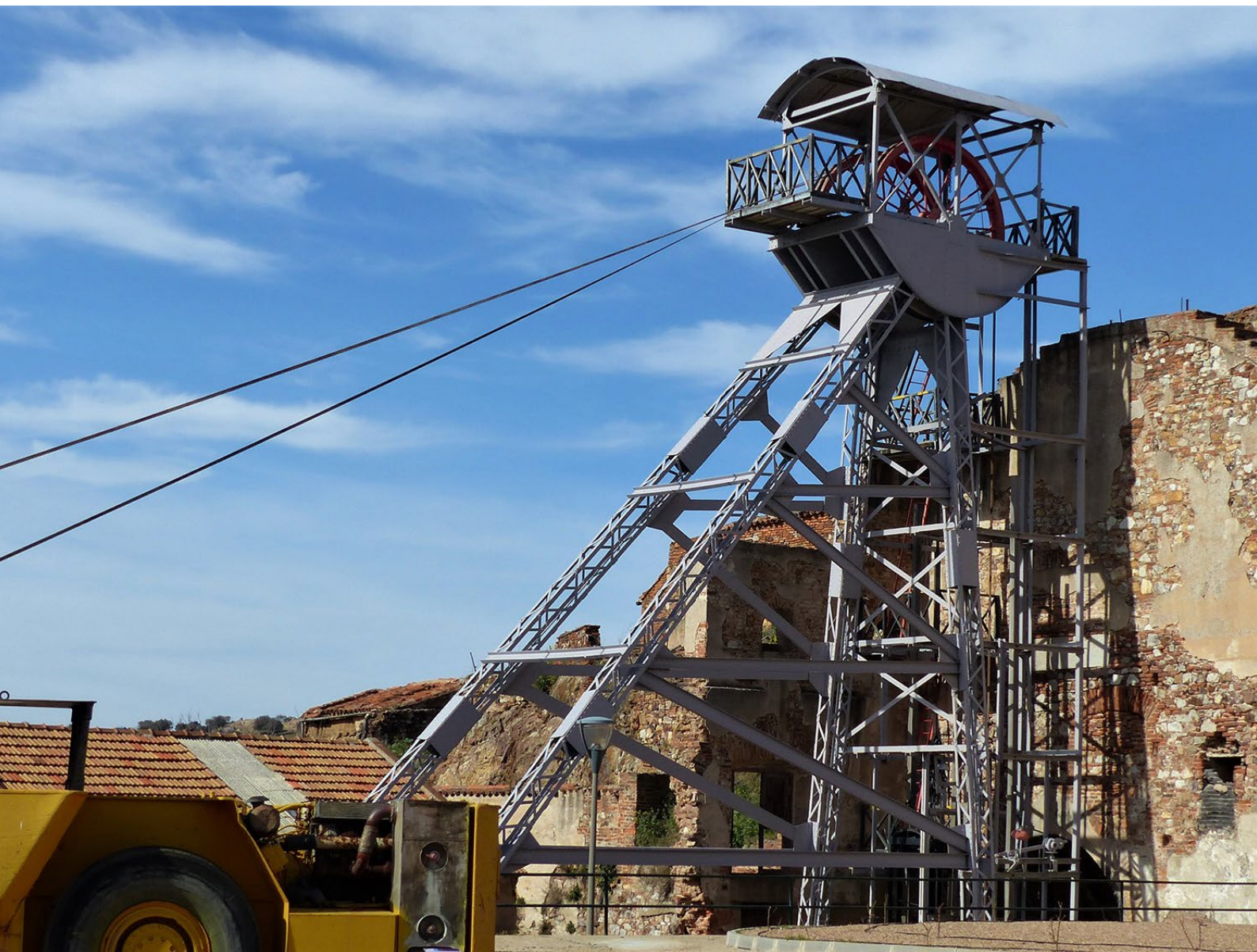
Castillete del Pozo San Aquilino, Almadén. Febrero 2015. Foto por el autor
