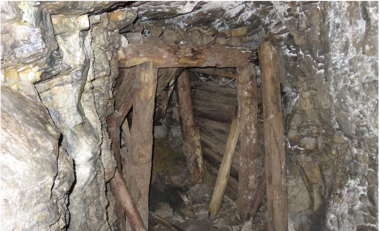
Antigua entibación con madera en la Mina del Pozo (Almadén). Foto: Borja Sainz de Baranda
